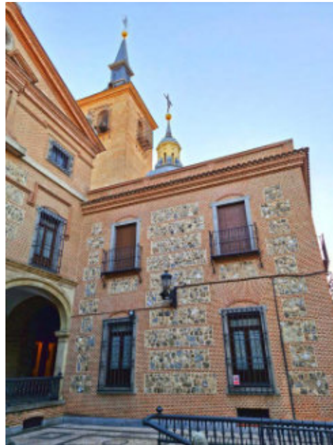
Iglesia de San Ginés, vista desde su entrada por la calle Arenal. Nótese los numerosos «aparejos toledanos», o «cajones de mampostería», rellenos con bloques fundamentalmente de chert y rocas carbonáticas. Foto del autor.
