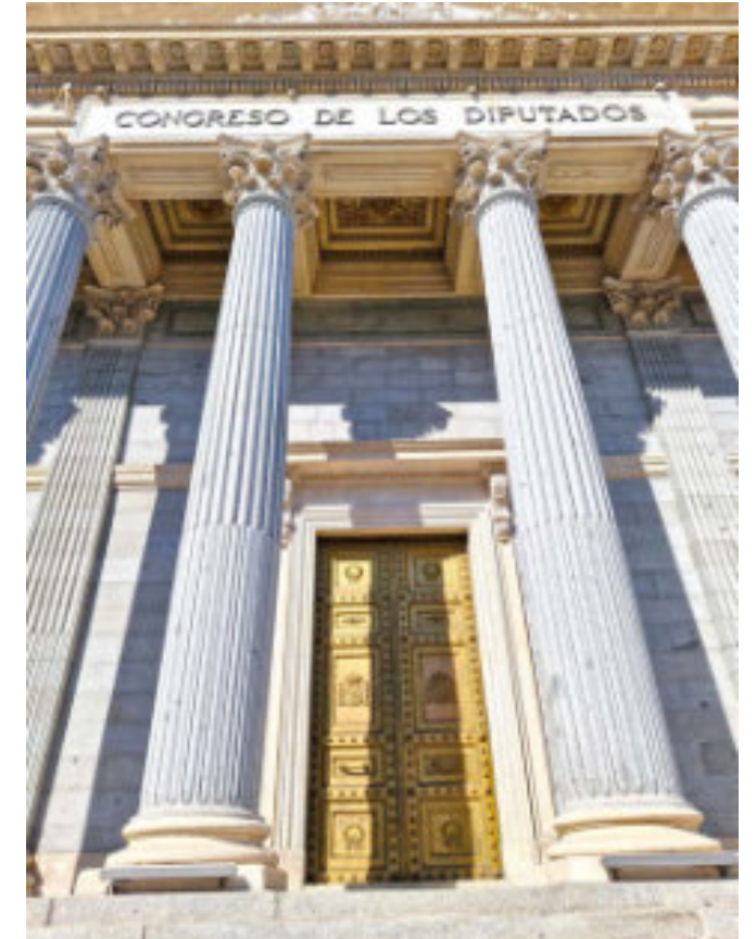
Fachada principal del Congreso de los Diputados. Las jambas y dinteles de color crema claro, fueron hechos a partir de dolomitas («piedra de Rueña»). Foto del autor.
