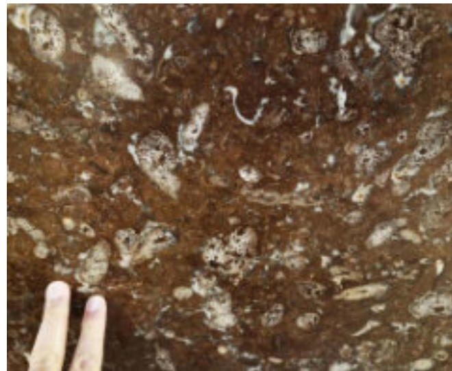
Detalle de una de las arcadas, donde se observa la roca carbonática cretácica de color rojo intenso, llena de rudistas. Foto del autor.
