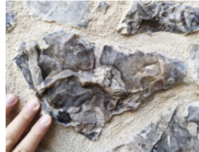
Detalle de un fragmento de chert dentro de la mampostería o «aparejo toledano». Foto del autor.
