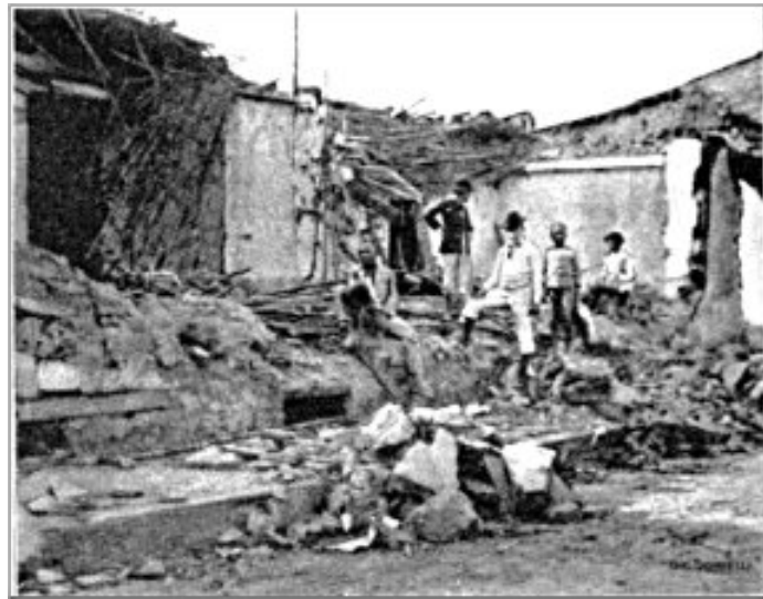
Terremoto en Caracas el 1 de octubre de 1800: casa colapsada.
