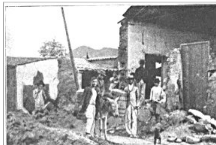
Terremoto en Caracas el 1 de octubre de 1900: Casa derrumbada.
