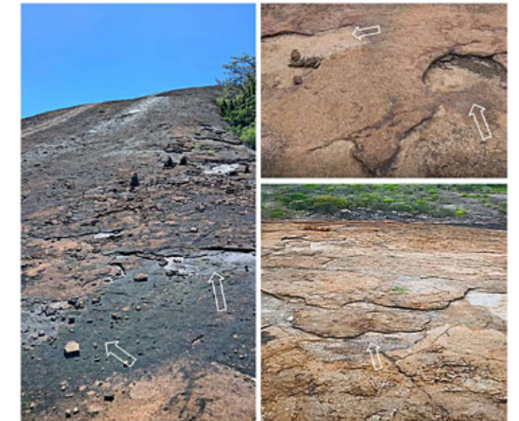
Figura 6. Detalle de la superficie del domo con desarrollo de microformas de meteorización, controladas por fracturas y meteorización diferencial. Se observan evidencias locales de spalling superficial, subordinadas a procesos de exfoliación que dominan la configuración del relieve (Foto izq. cortesía Daniel Moser Ramírez, Kayoas Adventures)
