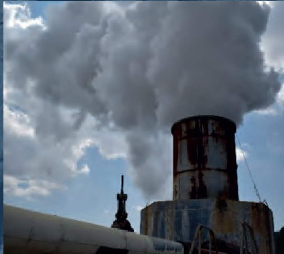
Figura 12. Pozo geotermal en el campo geotermoelectrico de Humeros en Puebla (Mengelle, 2025b).
