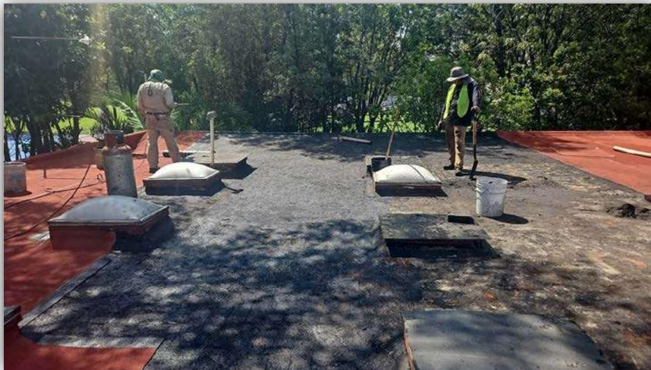
*Ilustración 17 - Impermeabilización de azoteas*
