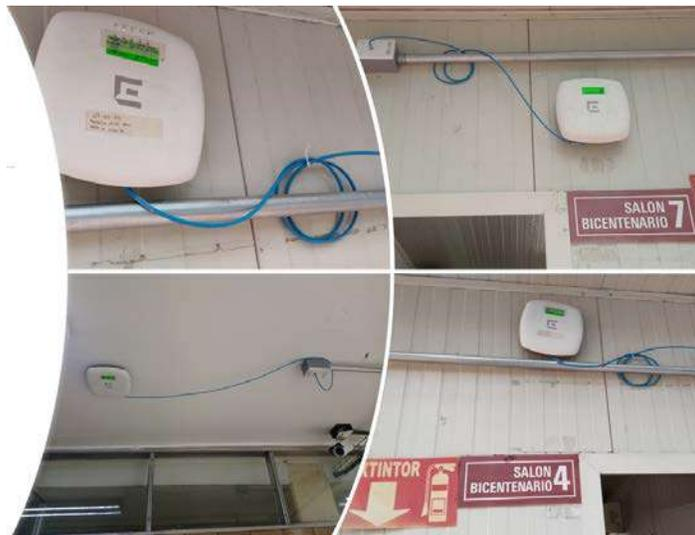
*Ilustración 11- Instalación de Access Point*
