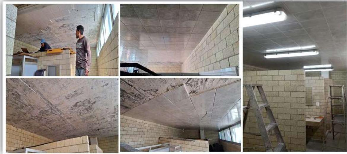
*Ilustración 16 - Retiro y colocación de azulejos en el gimnasio*
